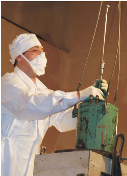
Лаборатория нейтронной физики им. И. М. Франка, 14 декабря. Разгрузка зоны реактора ИБР-30: извлечение топливных кассет (слева), высверловка вкладышей из диска основной подвижной зоны (справа)
