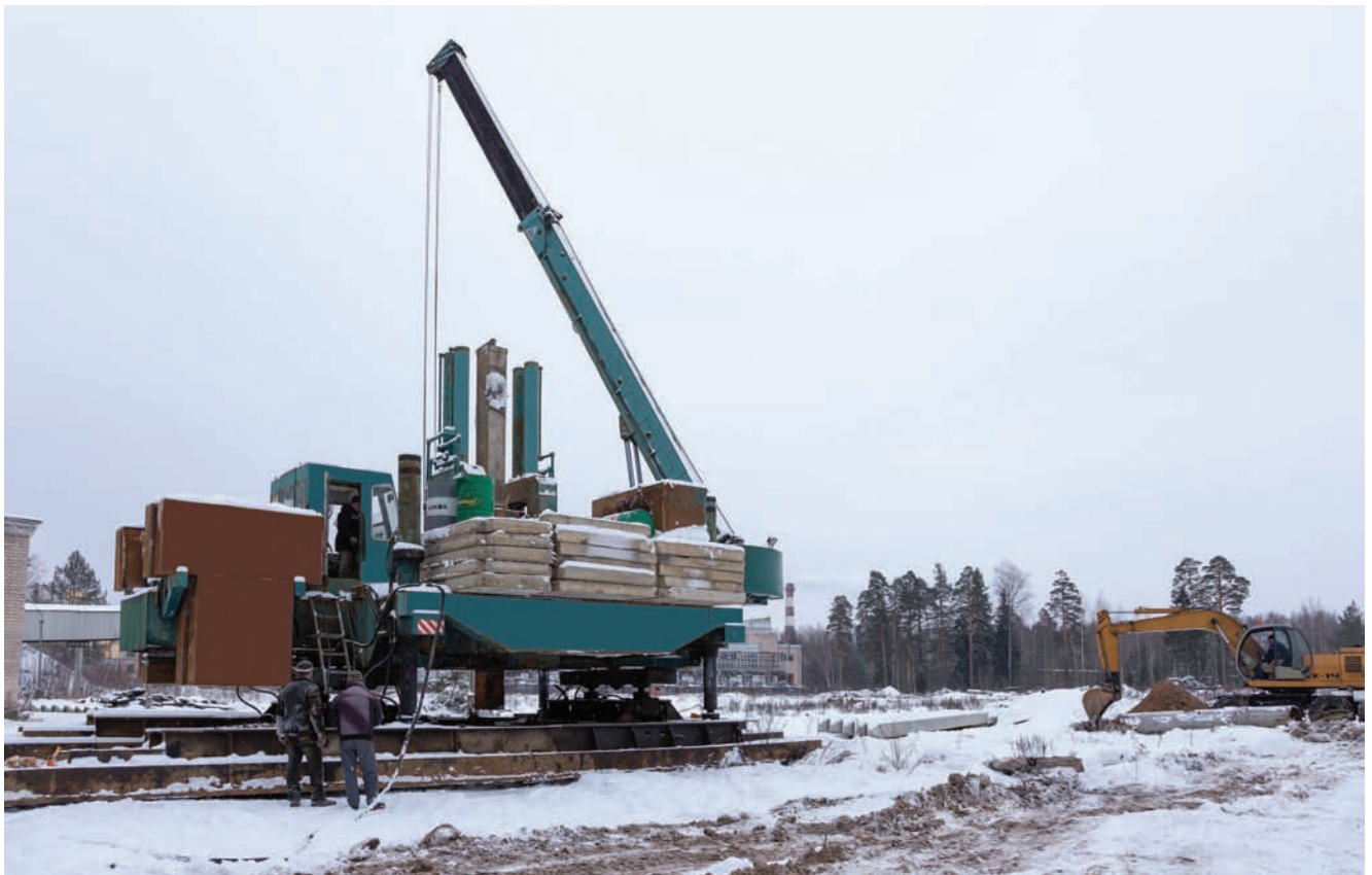
Лаборатория физики высоких энергий им. В. И. Векслера и А. М. Балдина, декабрь 2014 г. Площадка будущего комплекса NICA. Работает машина по вдавливаю свай
