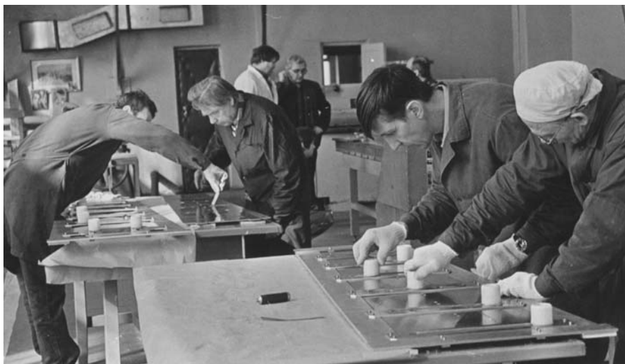
Рис. 7. Март 1996 г. Нанесение дозированного клеевого слоя в ЦОЭП ЛЯП
