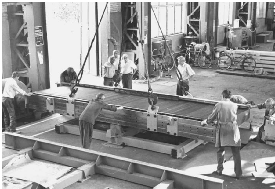
Рис. 24. Август 1999 г. ЛЯП ОИЯИ. Модуль №1 укладывается на транспортную опору для отправки в ЦЕРН
