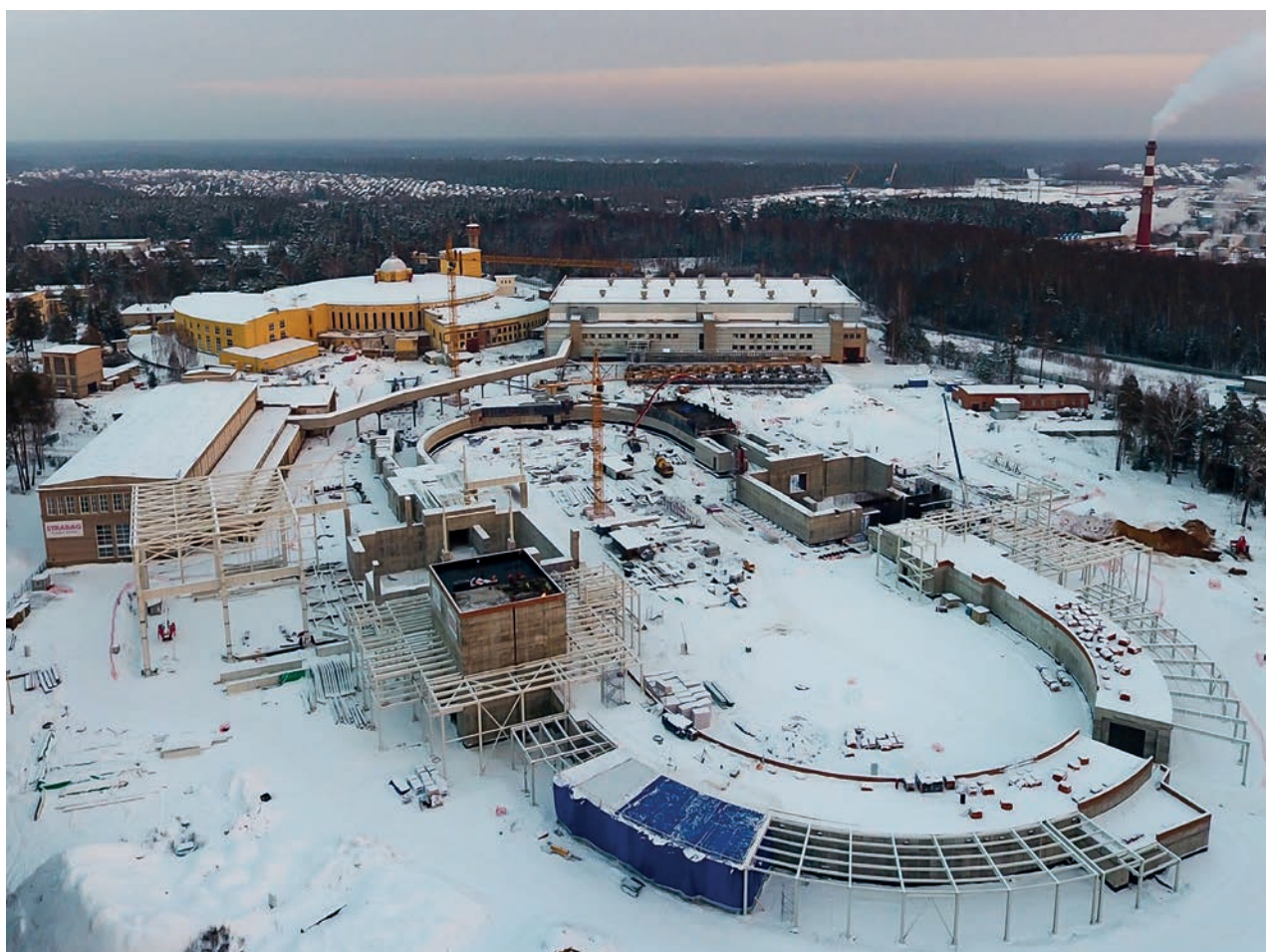
Строительная площадка комплекса NICA
