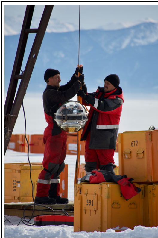
Очередной оптический модуль подготовлен к погружению
