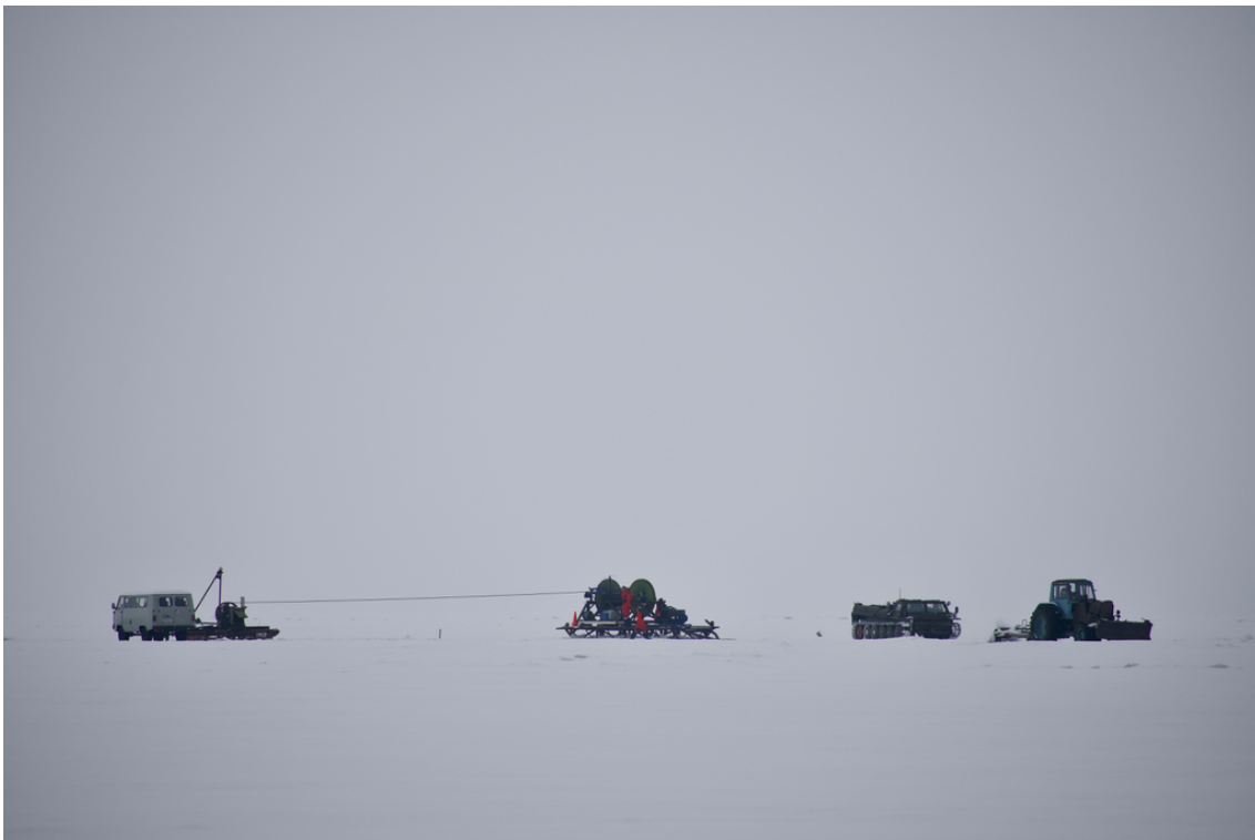
Прокладка донного опто-электрического кабеля от кластера до Берегового центра – 6 км
