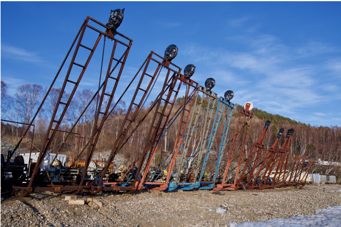
Лебедки – основной инструмент для выполнения глубоководных монтажных работ с поверхности льда
