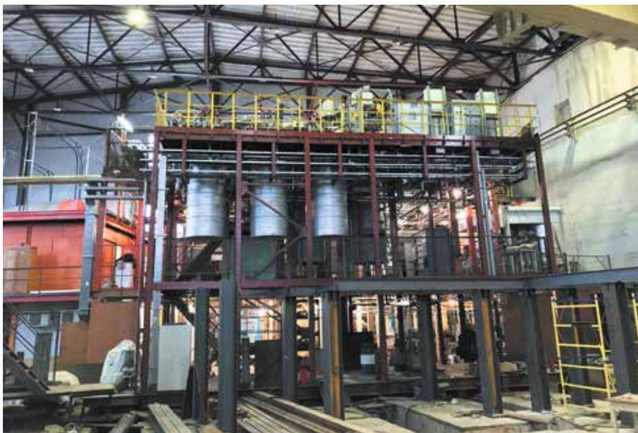
Новый гелиевый рефрижератор для охлаждения Бустера производства АО «НПО «Гелиймаш»
