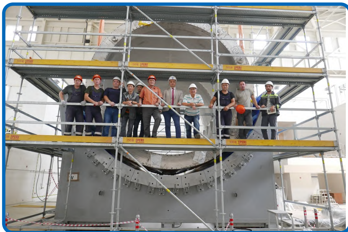
Рис. 6. Монтаж соленоида в ярмо магнита MPD.
