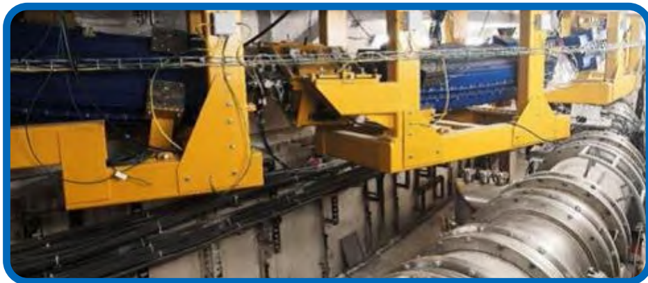
Рис. 2. Канал транспортировки пучков Бустер-Нуклотрон над туннелем Нуклотрона. Fig. 2. The Booster-Nuclotron transport channel located above the Nuclotron tunnel.
