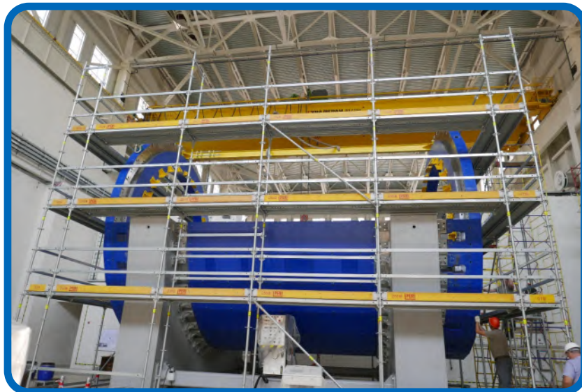
Рис. 5. Установлены опорные кольца и верхняя распорная технологическая балка.
