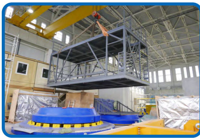
Рис. 7. Слева: Испытание траверсы для монтажа теплых катушек. Справа: Монтаж нижней части 4-уровневой подвижной платформы. Fig. 7. On the left: Testing the traverse for the installation of trim coils. On the right: Installation of the lower part of a 4-level movable platform.
