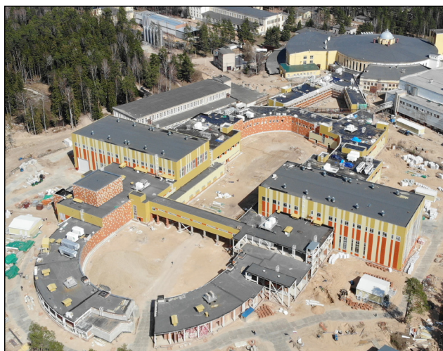
Рис. 6. Строительная площадка, апрель 2021 г.
