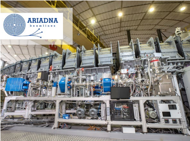
Станция СОЧИ введена в эксплуатацию (декабрь 2021 г.)
