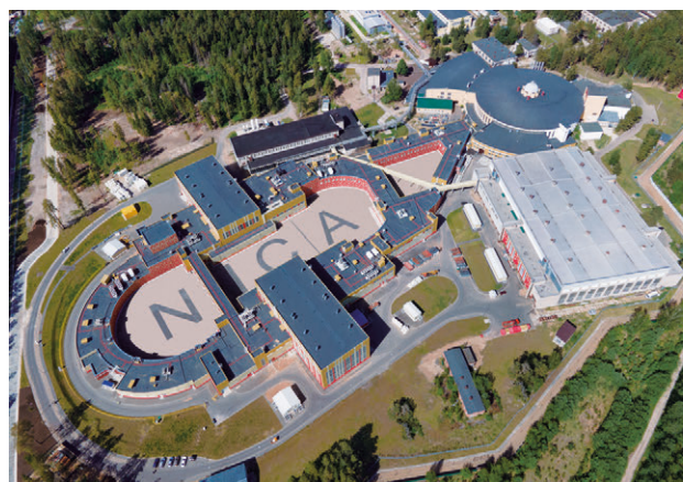
Комплекс NICA : историческое здание синхротрона, экспериментальный корпус и готовый к пуску коллайдер
