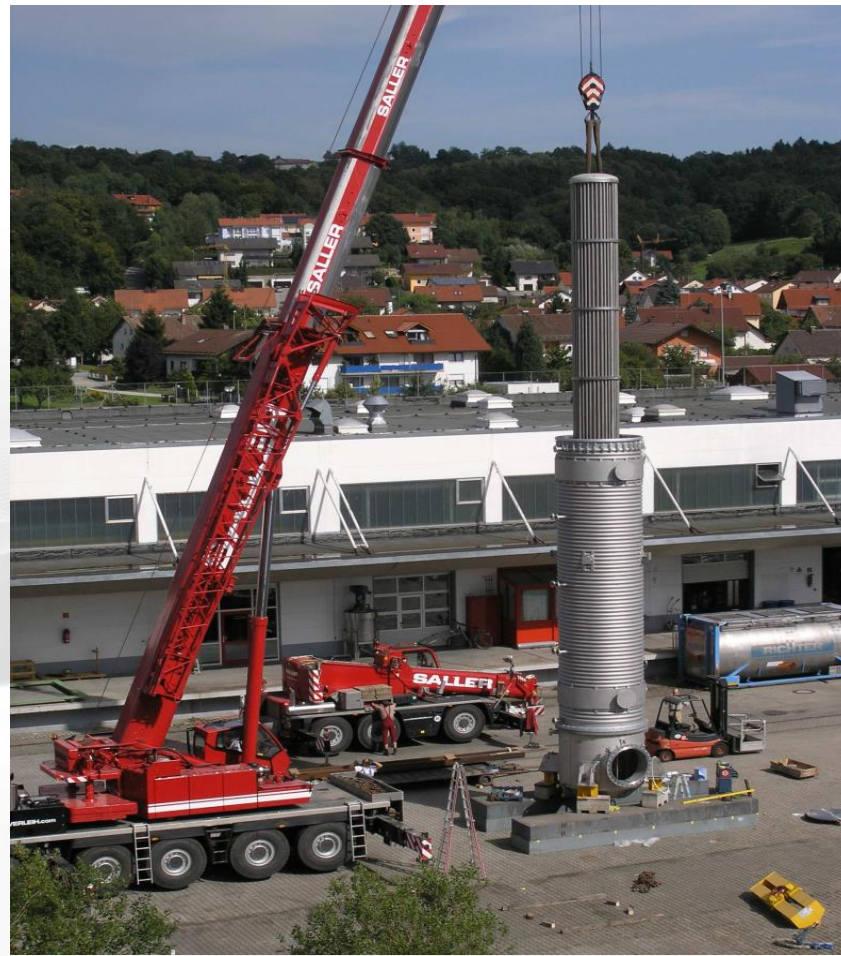
Корпус вакуумной дистиллирующей установки на этапе монтажа конденсатора
